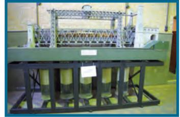
Henrichenburg. Was sich im ersten Moment nicht erschließt, die Hebeleistung wird nicht durch die vier Türme mit den großen Metallspindeln geleistet, sondern durch den Auftrieb von vier riesigen Schwimmern unter dem Trog. Erst am Model wurden die tatsächlichen Ausmaße und die Wirkungsweise der Anlage deutlich. Dazu
